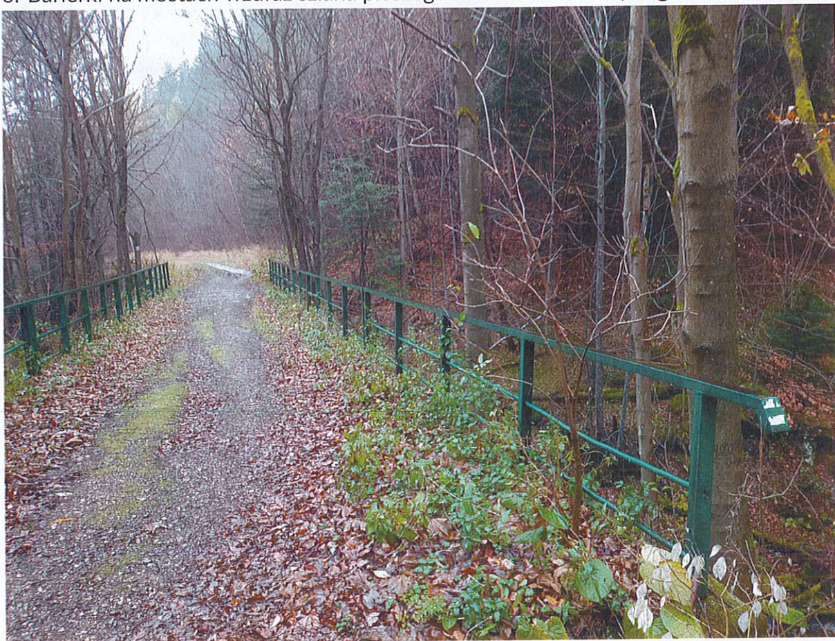
6. Barrierki na mostach wzdłuż szlaku pieszego Gorlice - Ożenna (droga nr 5).
