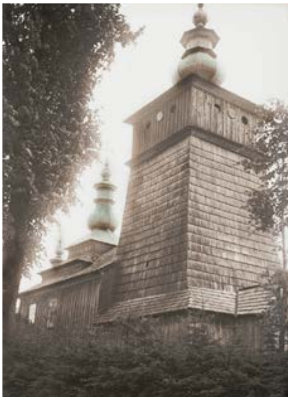
Nieistniejąca już cerkiew w Świerzowej Ruskiej (arch. MBL w Sanoku)
